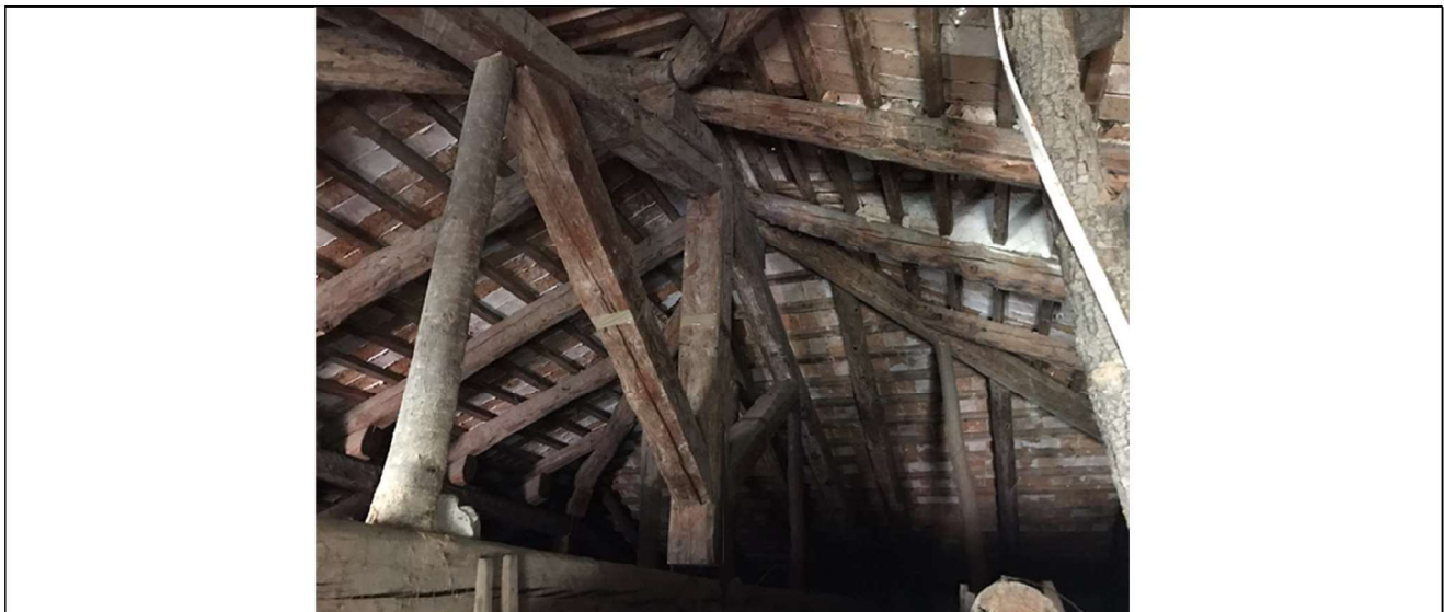
Figura 1: sottotetto villa, costituito da n.3 capriate con elementi lignei di diversa specie
